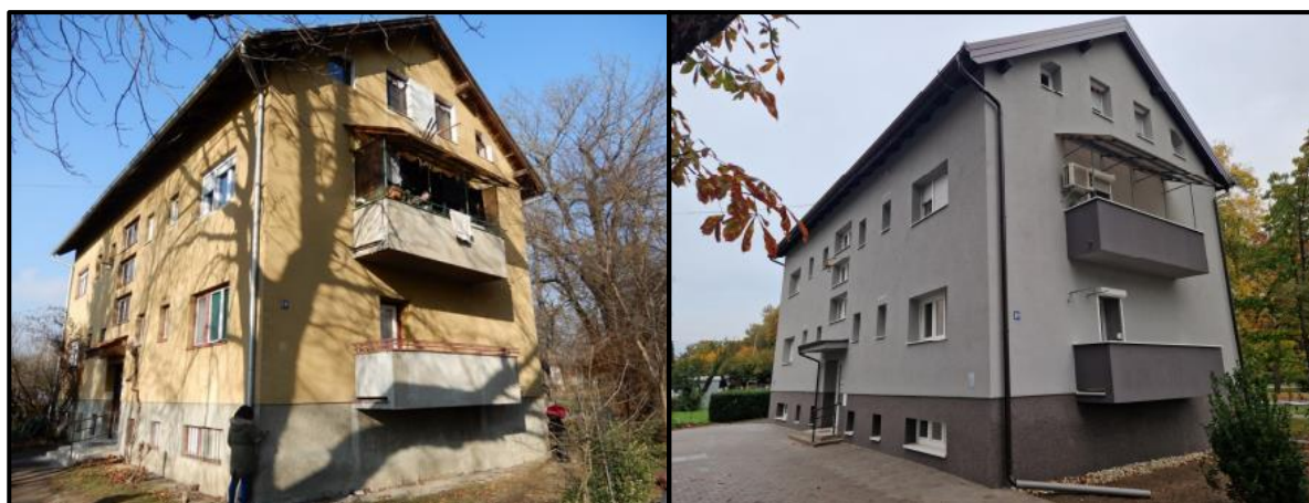
Slika 4: Višestambena zgrada na adresi Vladimira Nazora 24a, Čakovec (prije i poslije renovacije)
