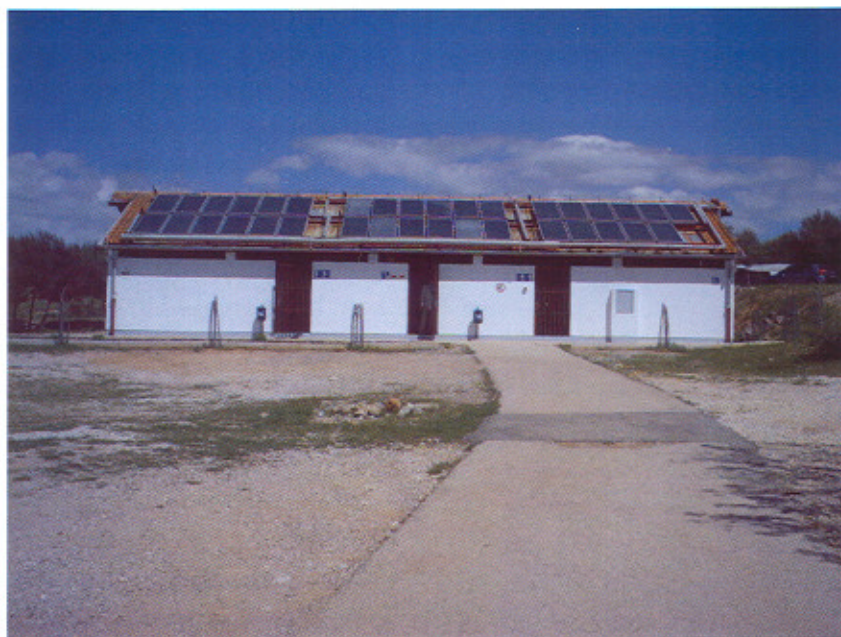
Slika 3. AC Politin: Sanitarni blok 2. – Sustav za grijanje vode nije u funkciji, površina kolektora 72 m 2
