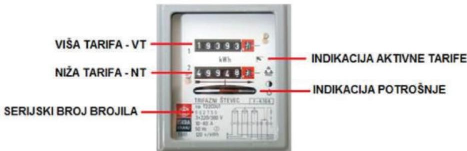
Slika 1. Elektromehaničko brojilo<sup>5</sup>
