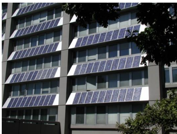
Slika 37. Primjena FN panela na fasadi zgrade
