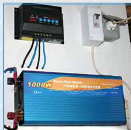
Fotonaponski sustav, inverter
