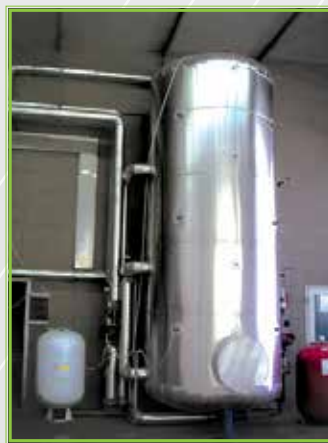
Akumulacijski spremnik potrošne tople vode
