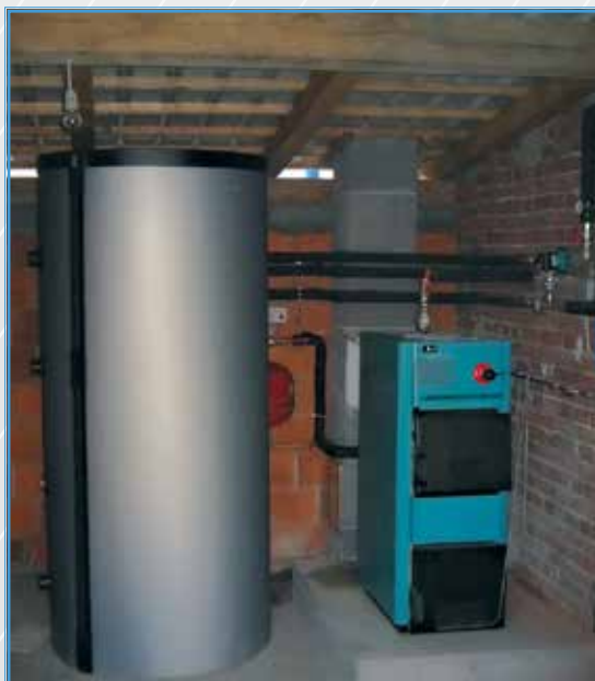
Kotao na kruto gorivo sa spremnikom ogrjevne vode
