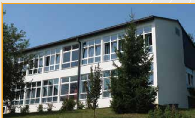
Obnovljena fasada i prozori škole
