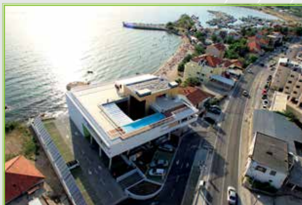
Solarni sustav grijanja potrošne tople vode
