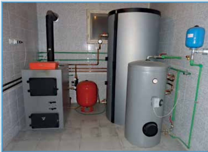
Sustav pirolitičkog kotla na kruta goriva obitelji Tepeš
