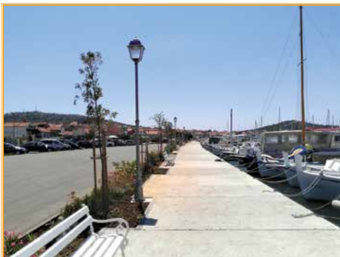
Solarna javna rasvjeta, Murter
