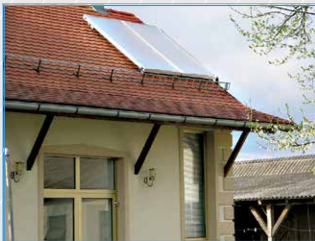
Solarni kolektori za pripremu potrošne tople vode
