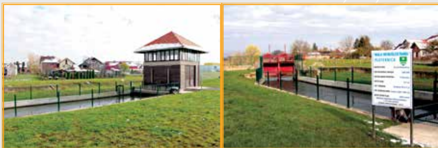
Mala hidroelektrana Pleternica
