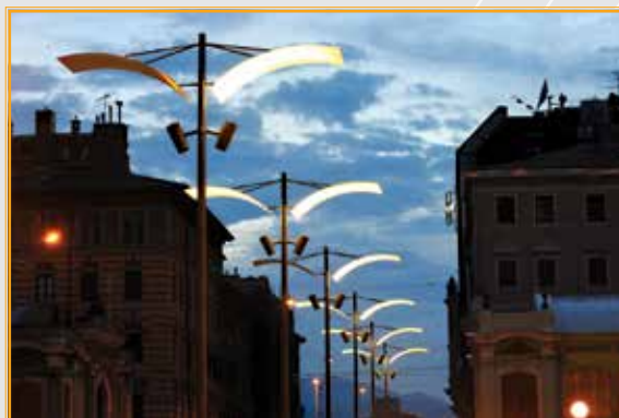
Energetski učinkovita javna rasvjeta Rijeka
