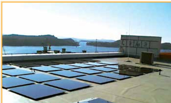
Postavljanje fotonaponskih panela
