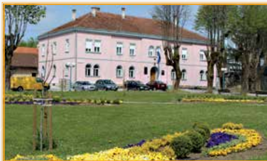
Obnovljeni prozori gradske uprave
