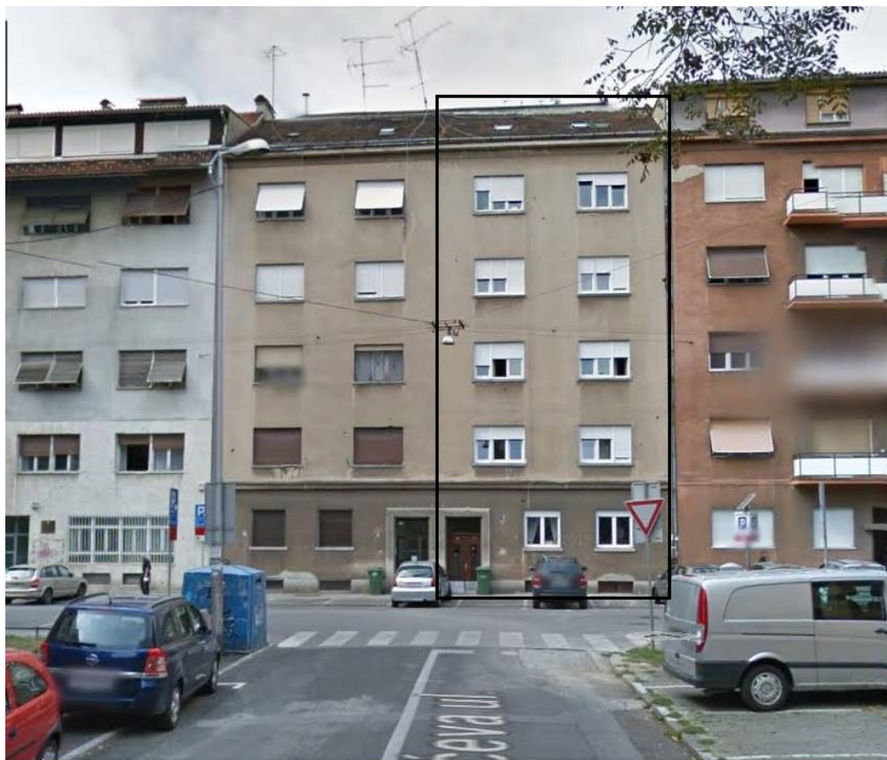
Slika 1. Pročelje zgrade adrese Ulica Crvenog Križa 10, pogled s istočne strane (Izvor: Google maps)
