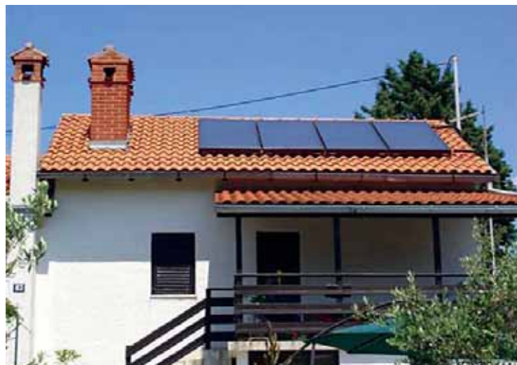
Slika 4. Primjer korištenja Sunčeve energije: sunčani toplinski kolektori
