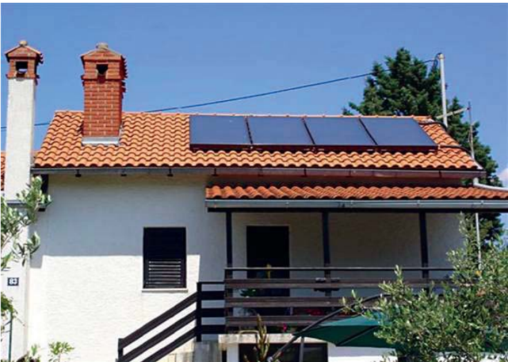
Slika 4. Primjer korištenja Sunčeve energije: sunčani toplinski kolektori
