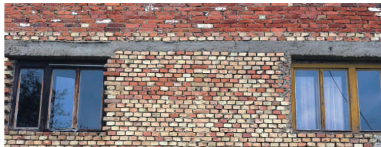
Prikaz [16] Tip izolacije s primjerom tipične gradnje energetski siromašnog kućanstva u Hrvatskoj.
