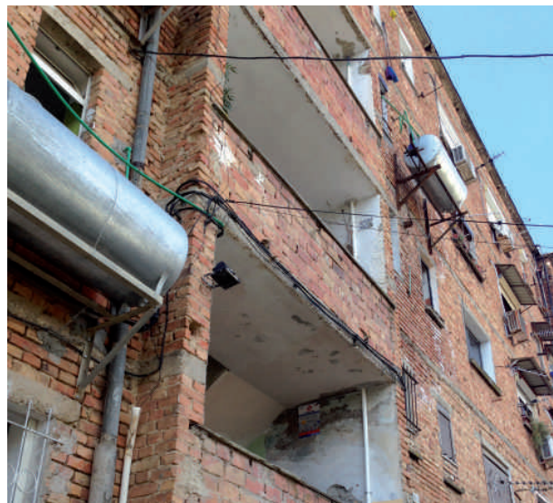
Prikaz [8A]: Neučinkoviti zidovi u Albaniji [snimljeni u Tirani 2016. tijekom posjeta kućanstvu]
