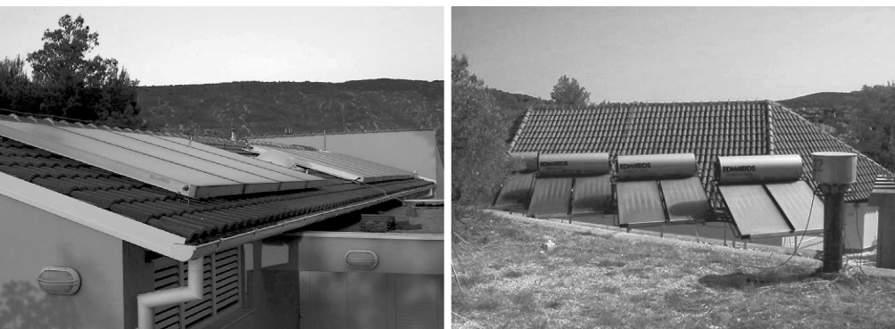
Slika 9 . Različiti primjeri postavljanja sunčevih kolektora i sustava
