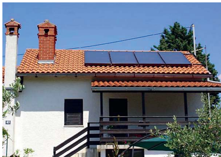
Slika 4. Primjer korištenja Sunčeve energije: sunčani toplinski kolektori
